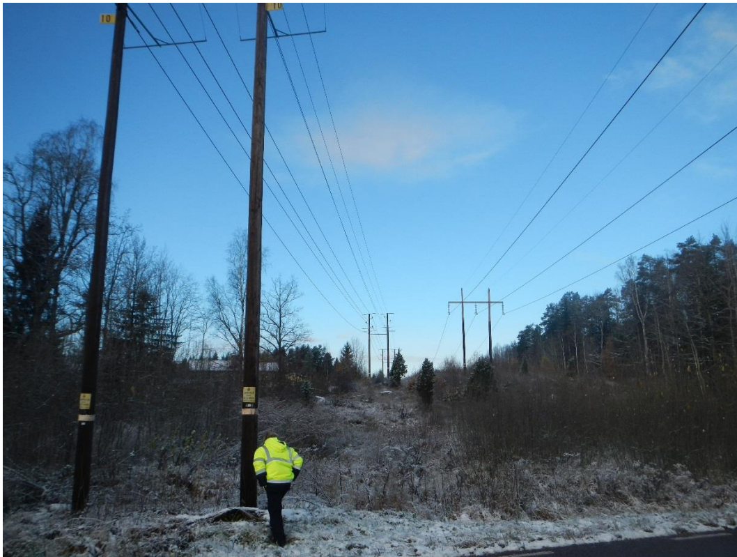
Figur 2. Bild tagen mot nordväst från väg 763 med befintlig 130 kV kraftledning (till höger i bild) utförd med träparstolpar parallellt med två lokalnätsledningar.
