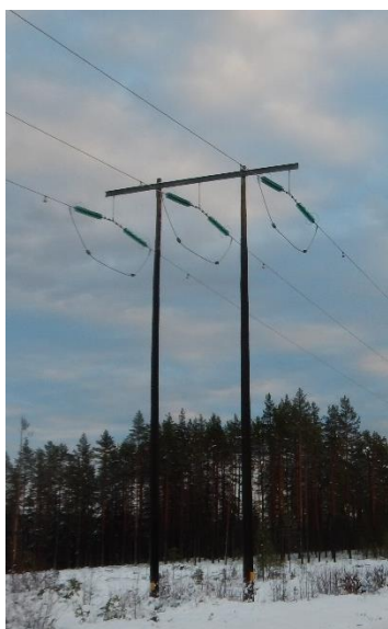
Figur 4. Träportalstolpe med horisontalplacerade faslinor
