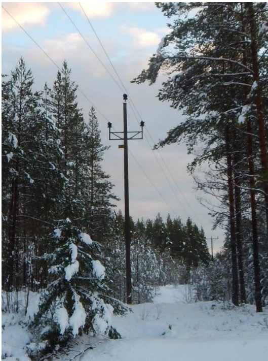
Figur 3. Enkelstolpe i trä med triangelplacerade faslinor
