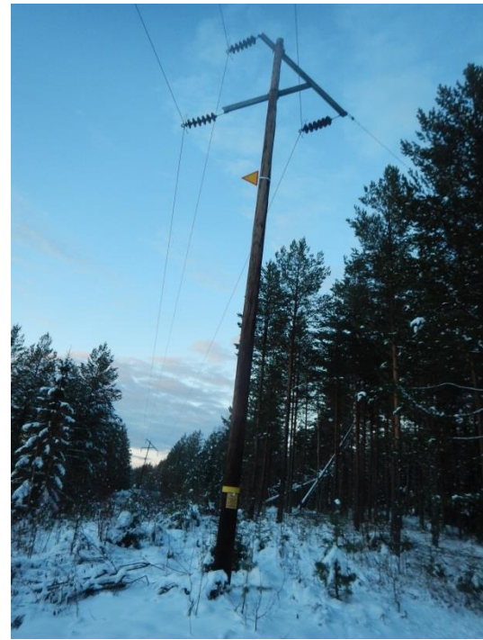
Figur 4. Vinkelstolpe i trä med triangelplacerade faslinor
