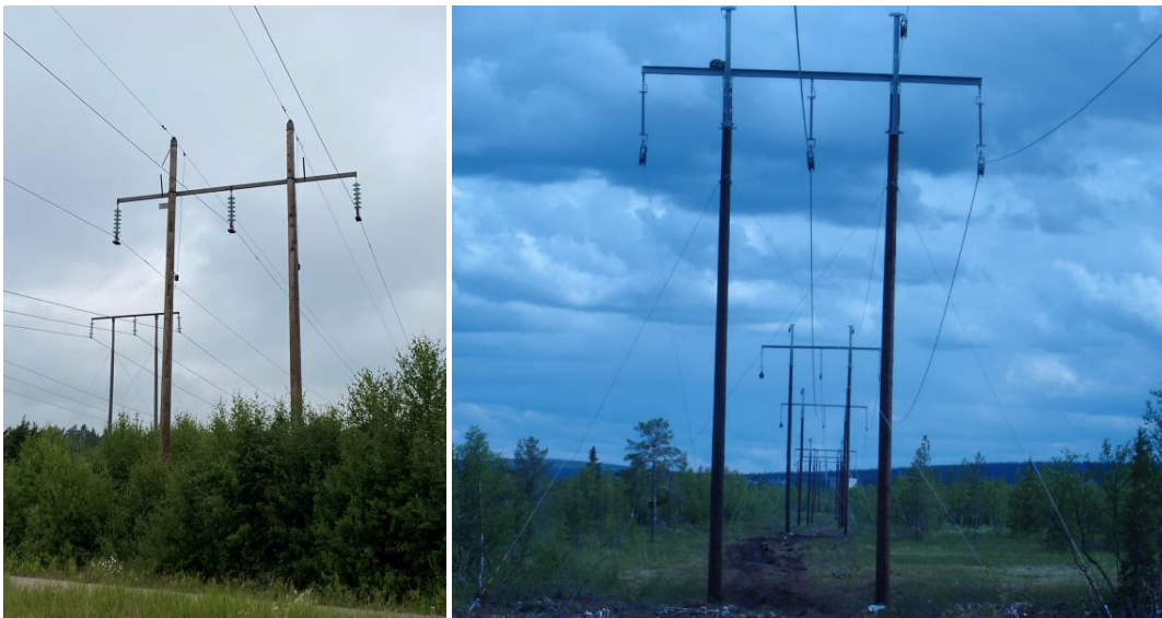
Figur 8. Exempel på portalstolpar i trä. I bilden till vänster har den högra stolpen topplinor medan den vänstra inte har det. Stolpen i den högra bilden har både staning och topplina.
