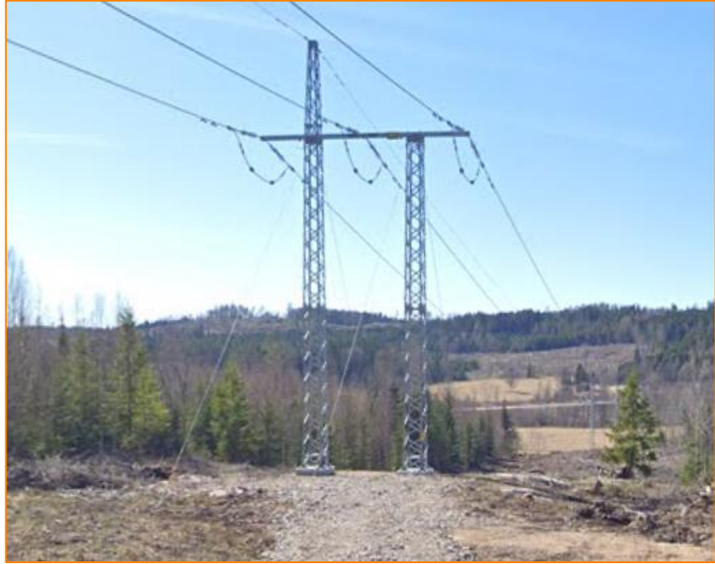
Figur 4. Portalstolpe i stål med en topplina.
