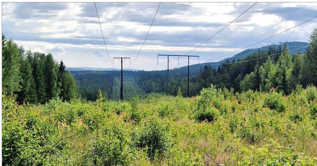
Figur 11. Befintliga ledningar som ägs av Svenska kraftnät och Trafikverket.
