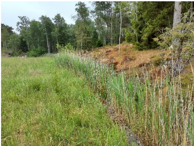
NVO 20: Öppet dike, klass 3 (preliminärt).
