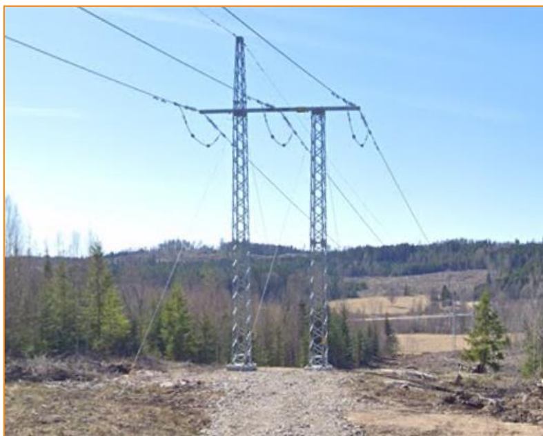
Figur 2. Portalstolpe i stål med en topplina.
