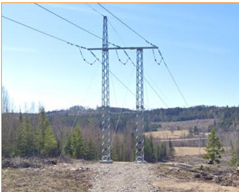
Figur 2. Portalstolpe i stål med en topplina.
