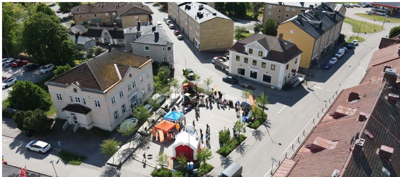
I Gullspång byggde Ellevio två nya nätstationer och sju kilometer nedgrävd kabel under 2024. Kabelarbetet var helt eldrivet.
