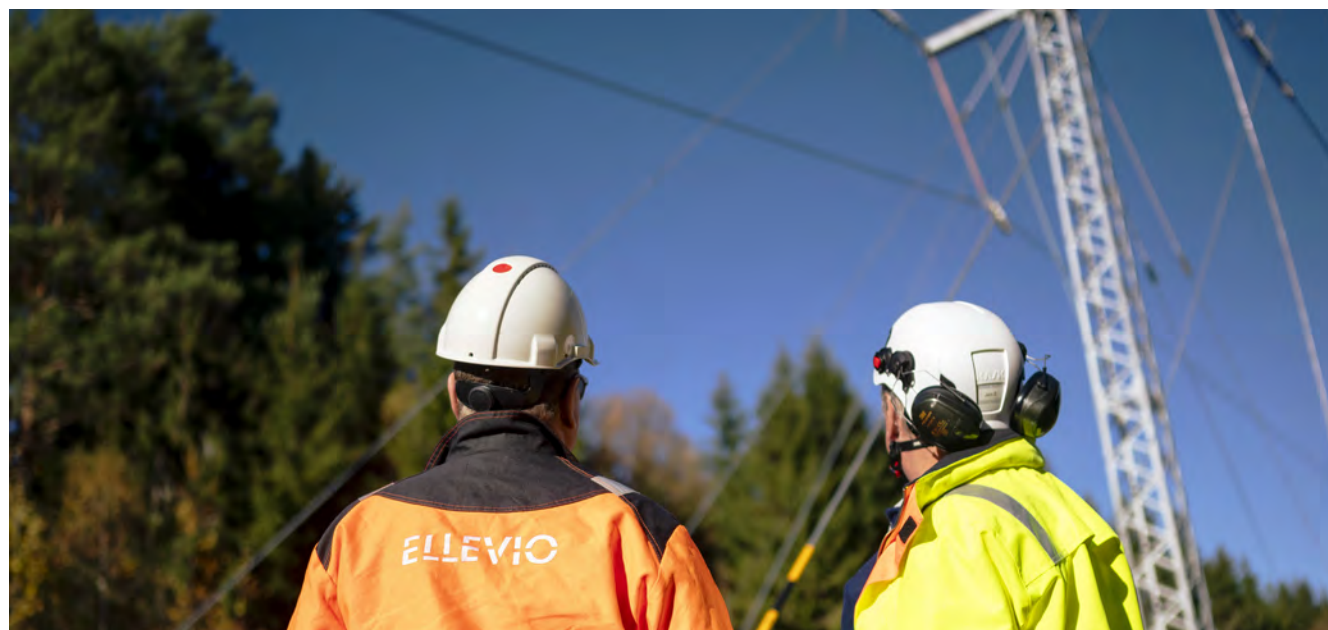
Ellevio genomför regelmässiga besiktningar av ledningsgator. Det kan ske till fots, via helikopter eller med drönare.
