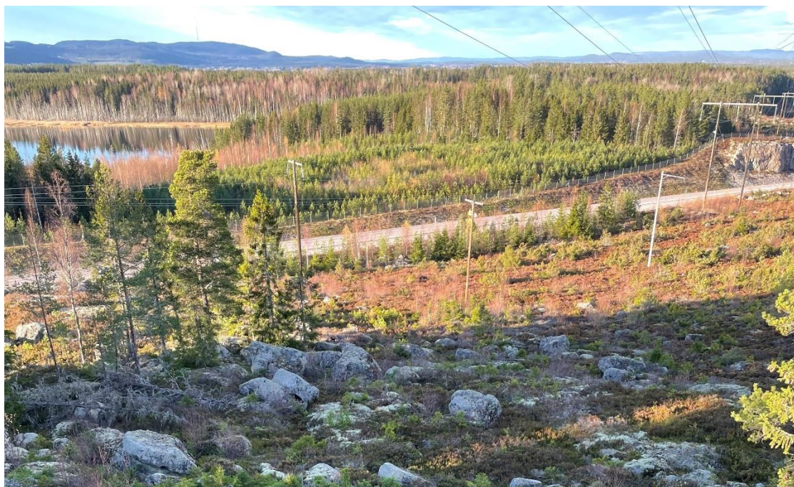
Figur 12. Foto som illustrerar landskapet med vägar och kraftledningar i skogsmark. Svks 220 kV ledning korsar här väg E4. De mindre ledningarna är Trafikverkets 130 kV och Ellevios 40 kV ledning.
