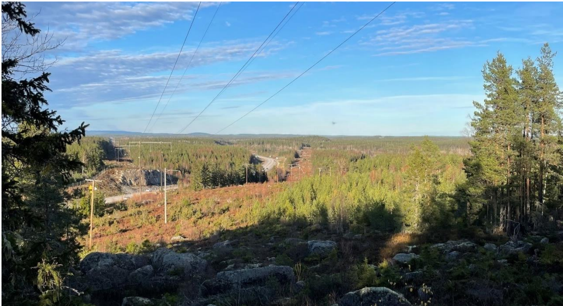
Figur 11. Foto som illustrerar landskapet med vägar och kraftledningar i skogsmark. I fotot syns väg E4, Svks 220 kV ledning, Trafikverkets 60 kV ledning och Ellevios 40 kV ledning.
