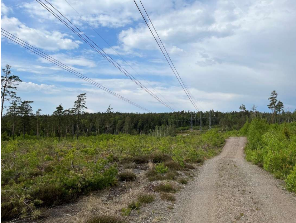
Figur 18. Bild där alternativet korsar Svenska kraftnäts befintliga 400 kV ledning.
