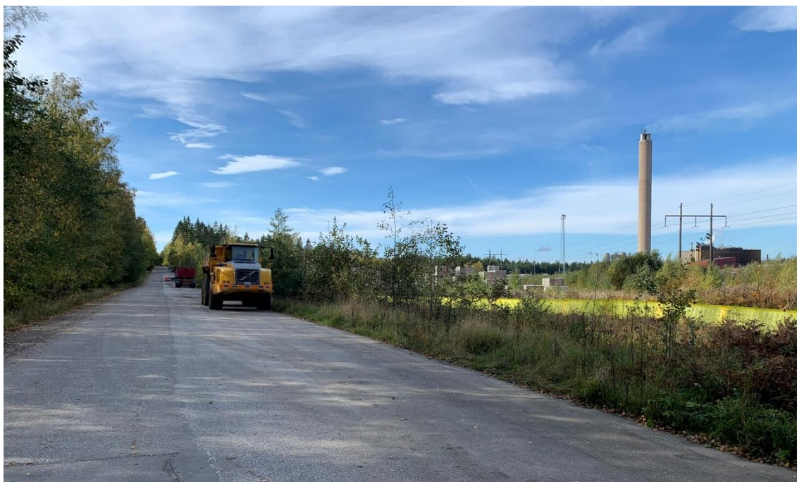
Figur 9. Foto på Truckvägen, med befintlig ledning och Paroc synliga t v i bild. Blickriktning sydväst. Sträckning 1A följer Truckvägens vänstra sida.
