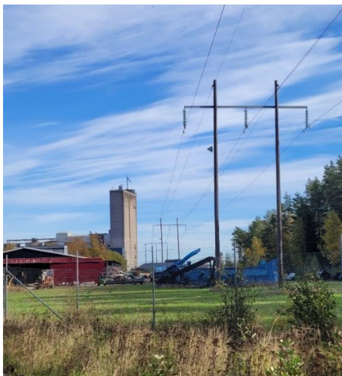
Figur 4 . Träportalstolpar tillhörande befintlig ledning L33, direkt öst om det aktuella projektområdet.
