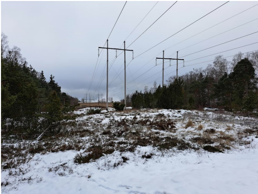
Figur 9. Befintlig ledningsgata mot norr.
