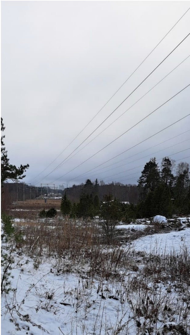
Figur 12. Befintlig ledningsgata vid passage över Dingelsundsådran. Skoghalls bruk syns i horisonten.
