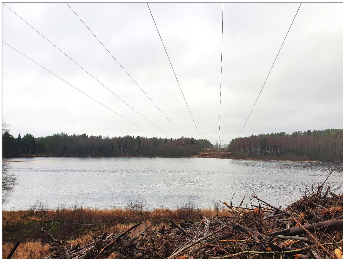
Figur 6. Korsning av Klarälven, KL60 till vänster i bild. Parallellgående till höger är annan luftledning tillhörande Ellevio.
