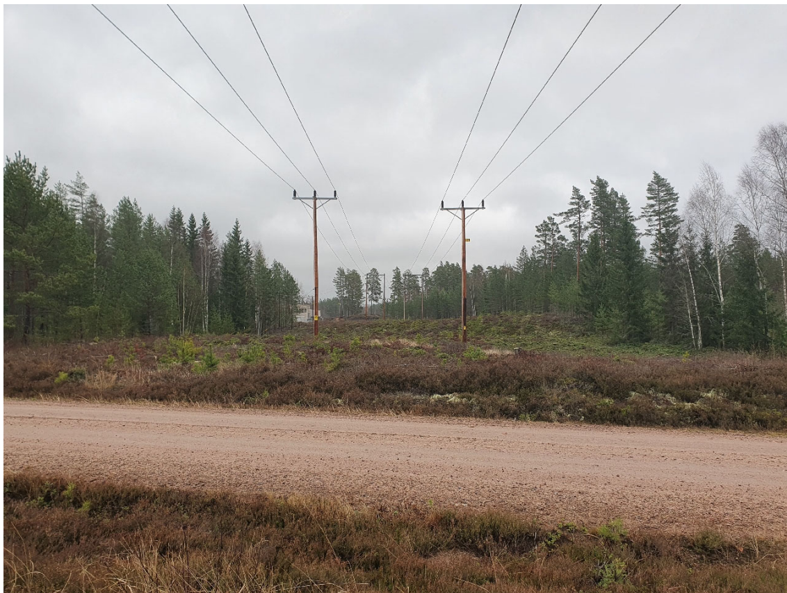
Figur 3. Enbenta trästolpar tillhörande KL 60 (vänster) och KL61 (höger).
