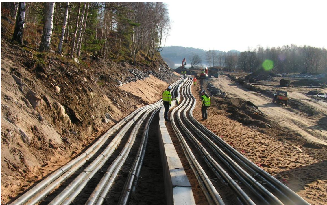
Figur 7. Exempel på arbetsområde (foto från tidigare projekt med två 145 kV ledningar med fyra förband vardera).
