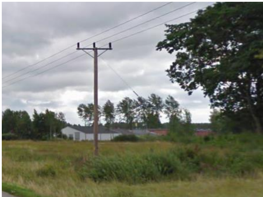
Figur 3. Enkelstolpe med överliggande stålregel samt stående isolatorer.
