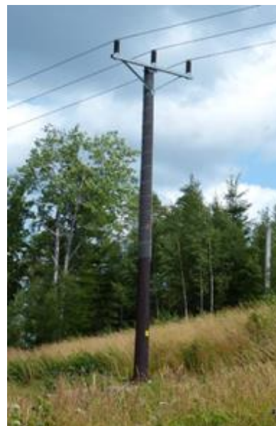
Figur 3 Exempel på enkelstolpe. Källa: Ellevio AB
