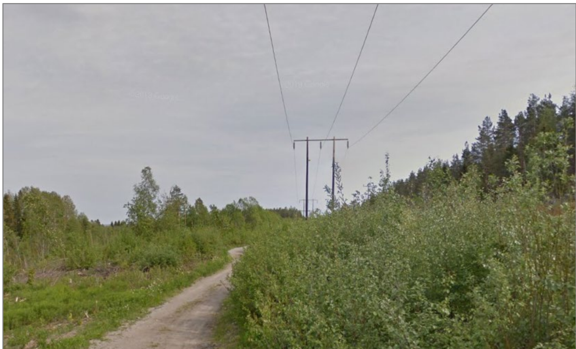
Figur 6. Landskap runt befintlig luftledning AL21S1/AL11S1.
