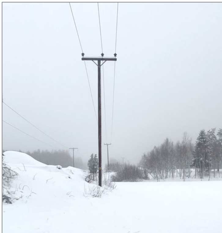
Figur 4. Exempel på enkelstolpe tillhörande delen A11S1 av den aktuella ledningssträckningen.
