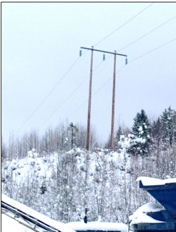
Figur 4. Portalstolpe tillhörande AL12S1.
