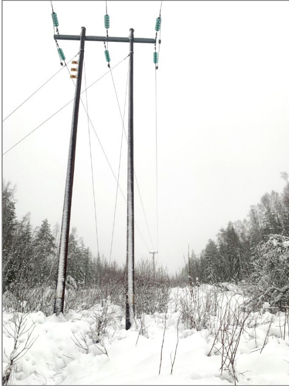
Figur 3. Portalstolpe tillhörande AL11S2S3.
