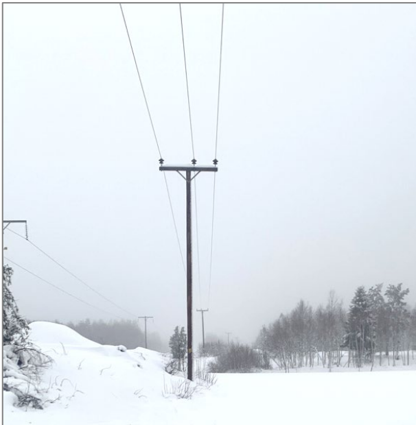
Figur 4. Enkelstolpe tillhörande AL11S2S3.
